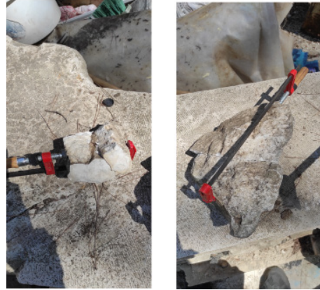
Fig. 40. Yapıştırma İşlemi Sonrası Taşın Durumu
