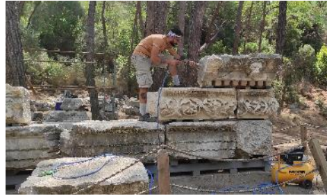
Fig. 37. Kompresör Yardımıyla Çatlakların Temizlenmesi
