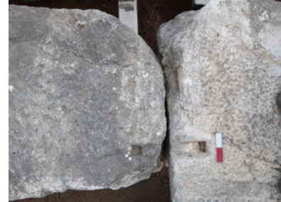
Fig. 33. Hadrianus Kapısı Friz Bloğu U/Çengel Kenet Detayı
